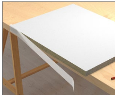
3. Tilpas med 5 mm overlappning på forsiden, og tryk.
